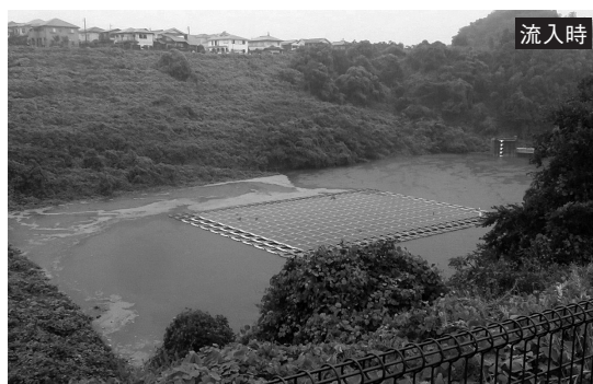
写真2 雨水調整池に設置されたフロート式太陽光パネル
