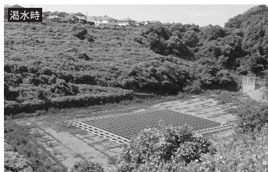
写真2 雨水調整池に設置されたフロート式太陽光パネル
